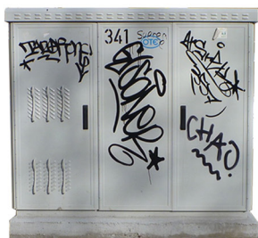
1. Νέος καλωδιοκατανεμητής ΟΤΕ (ΚΑΦΑΟ)
